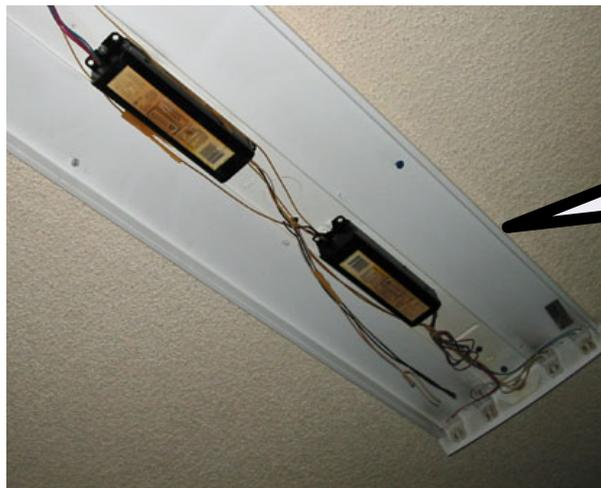
従来の蛍光灯や水銀灯には、電流・電圧を制御するための「安定器」が必ずついています。
